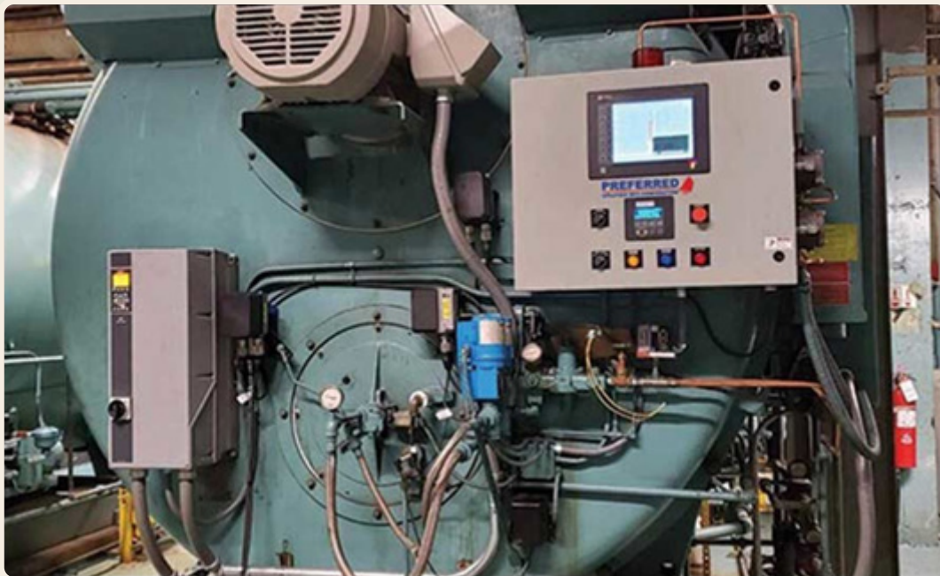
شکل شماره ۵: یک نمونه از سیستم Oxygen Trim Control Systems
