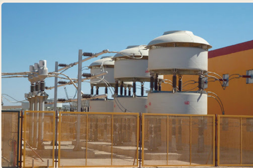
شکل شماره ۱۲: یک نمونه از سیستم SVC در کارخانه فولاد
