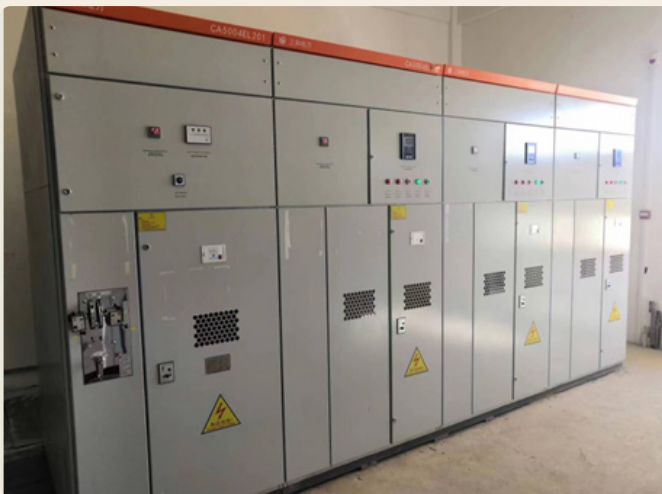
شکل شماره ۱۳: یک نمونه از سیستم STATCOM در صنایع فولادی
