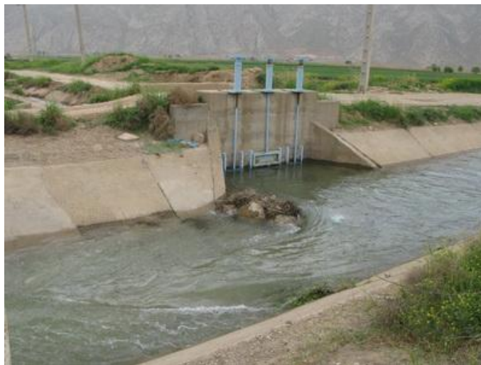
شکل ۸- نمایی از یکی از آبگیرهای کانال درجه ۳ در شبکه آبیاری درودزن (گذاشتن مانع در پایین دست دریچه)
